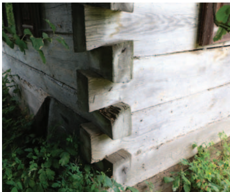
Fot. 16. Zawęglowanie ścian na rybi ogon, Wyryki,
