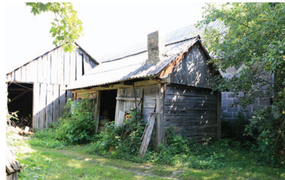
Fot. 11. Szopa o konstrukcji sumikowo-łatkowej, Wryki
