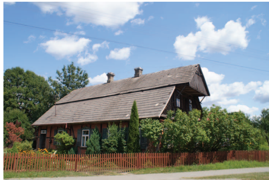
Fot. 12. Wiryki Adampol nr 70/72 – dom w konstrukcji szkieletowej, inaczej ryglowej (mur pruski)
