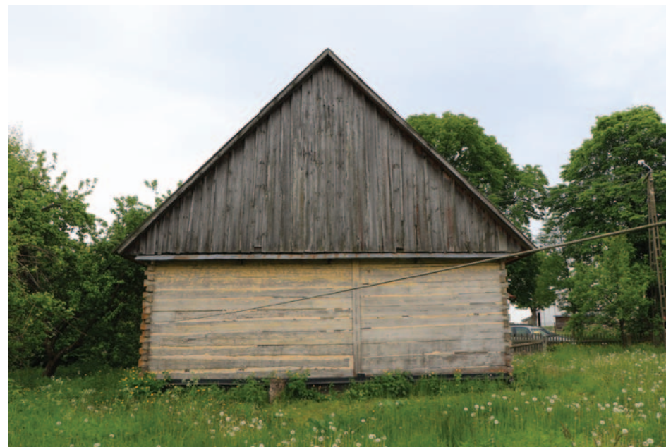
Fot. 20. Konstrukcja sumikowo-łątkowa jako pomocnicza w ścianie szczytowej, Wyryki
