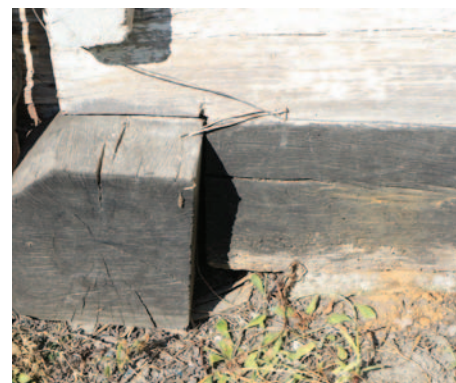
Fot. 18. Podwalina ułożona na ziemi, Wyryki,
