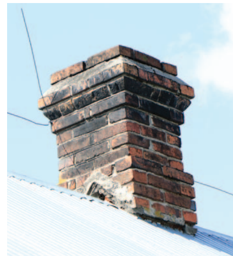
Fot. 27. Komin, Wyryki
