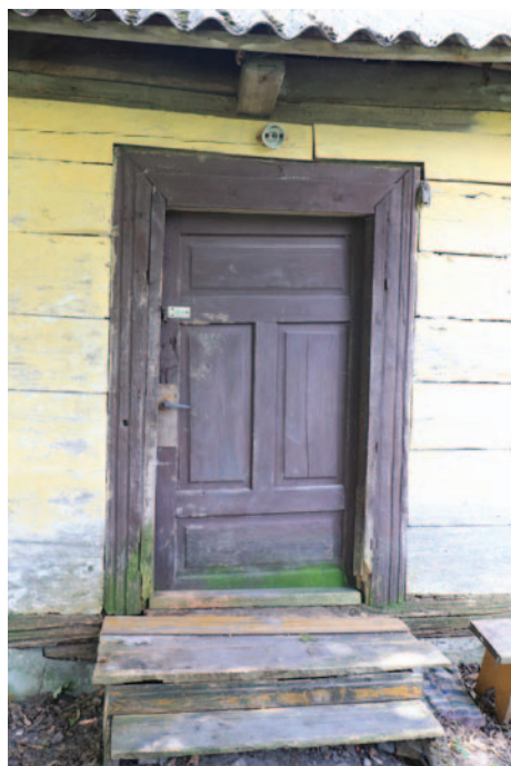
Fot. 31. Drzwi filungowe, jednoskrzydłowe, Wyryki
