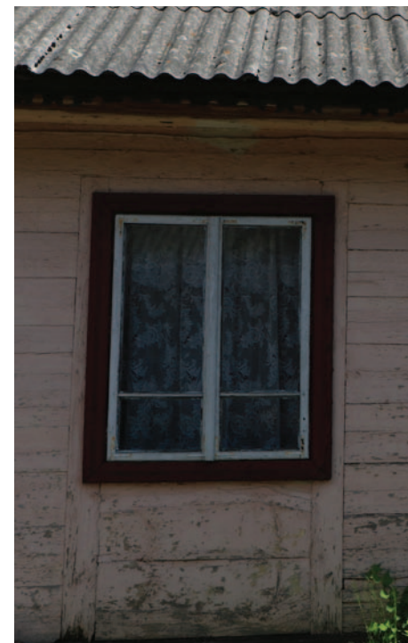
Fot. 30. Okno czteroszybowe, futryna pruska, Wyryki,
