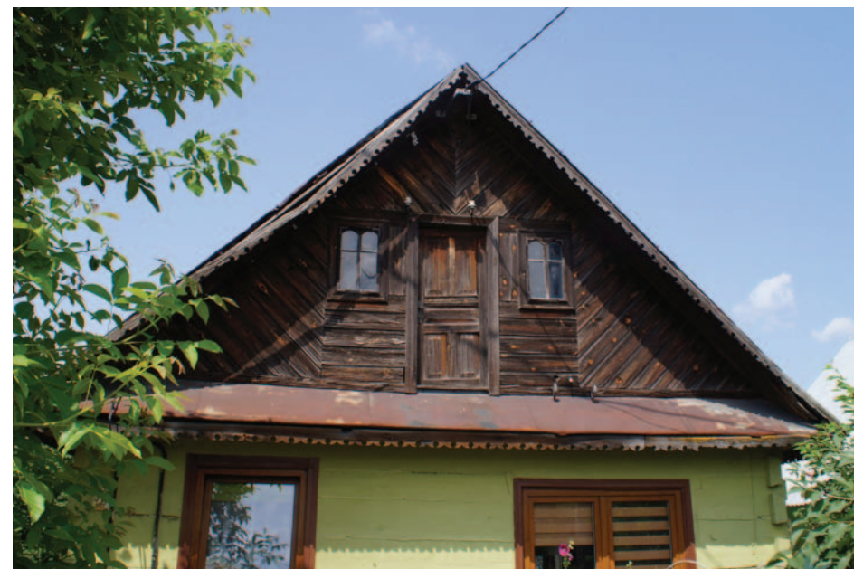
Fot. 15. Wyryki Adampol nr 311 - ozdobne szalowanie szczytu dachu oraz dekoracja snycerska wiatrownic
