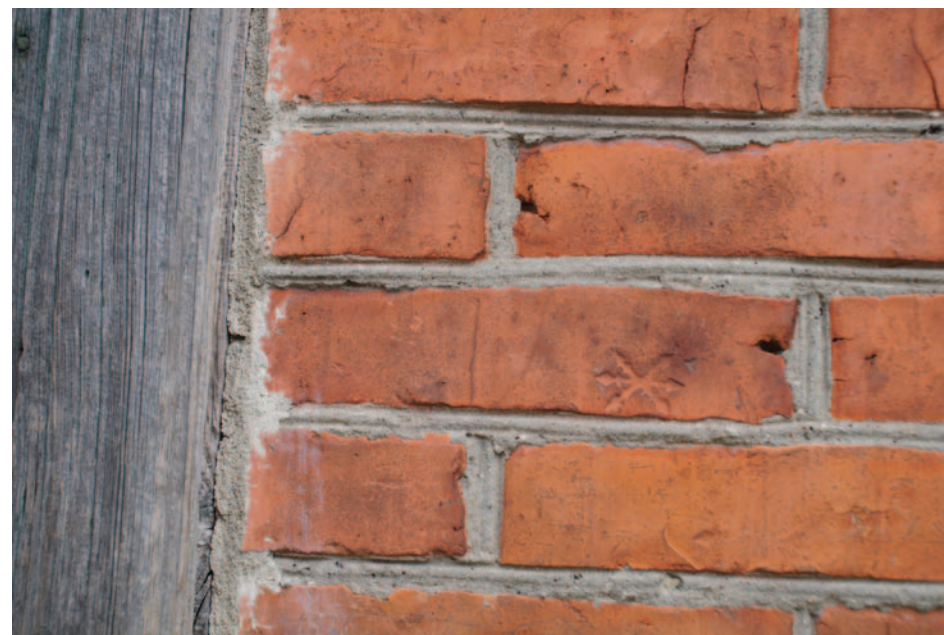
Fot. 13. Wiryki Adampol nr 70/72 – dom w konstrukcji szkieletowej, inaczej ryglowej (mur pruski). Szkielet wypełniony murem z cegły, z oznaczeniem cegielni Zamoyskich
