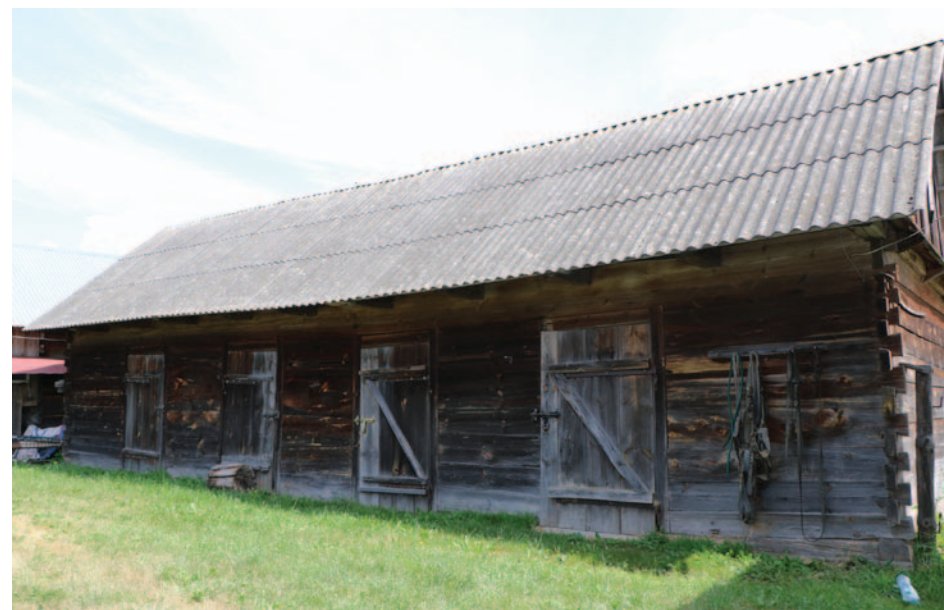
Fot. 7. Budynek gospodarczy dla zwierząt hodowlanych, Wyryki
