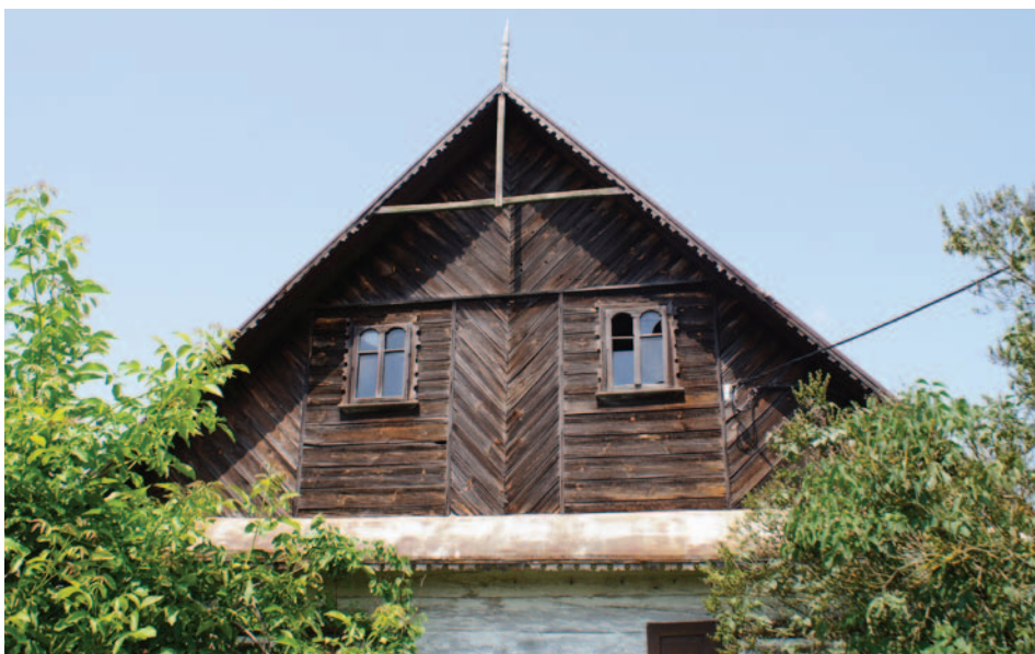
Fot. 14. Wyryki Połud nr 209 – ozdobne wiatrownice i pazdur w szczycie chałupy
