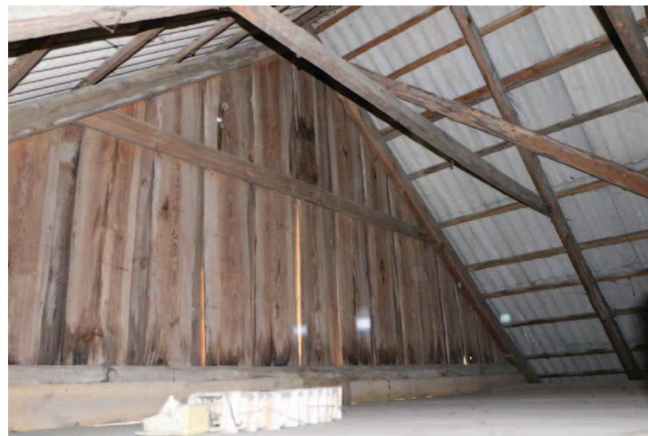
Fot. 21. Konstrukcja dachu krokwiowa, Wyryki
