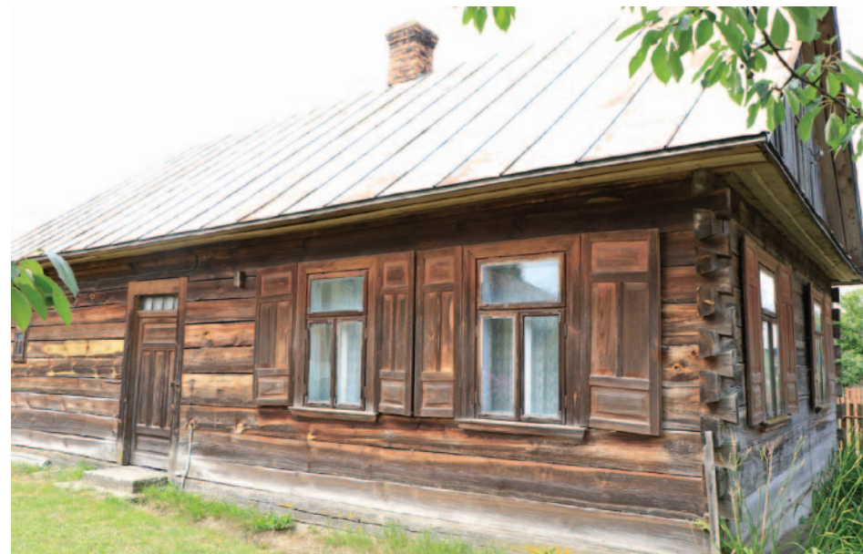
Fot. 41. Chałupa asymetryczna, dwutraktowa z dachem dwuspadowym, Wyrki
