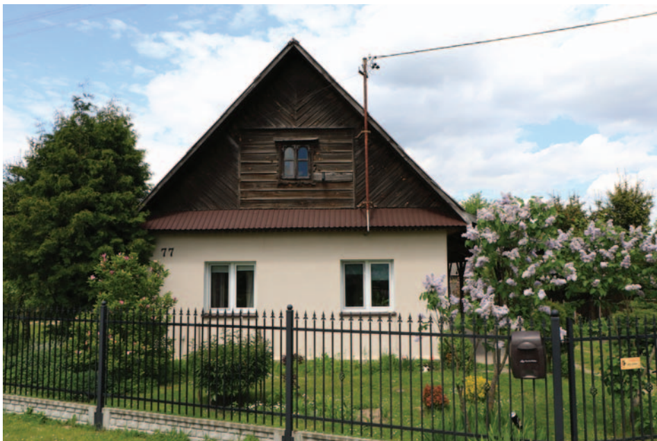
Fot. 25. Szczyt dachu, Wyryki
