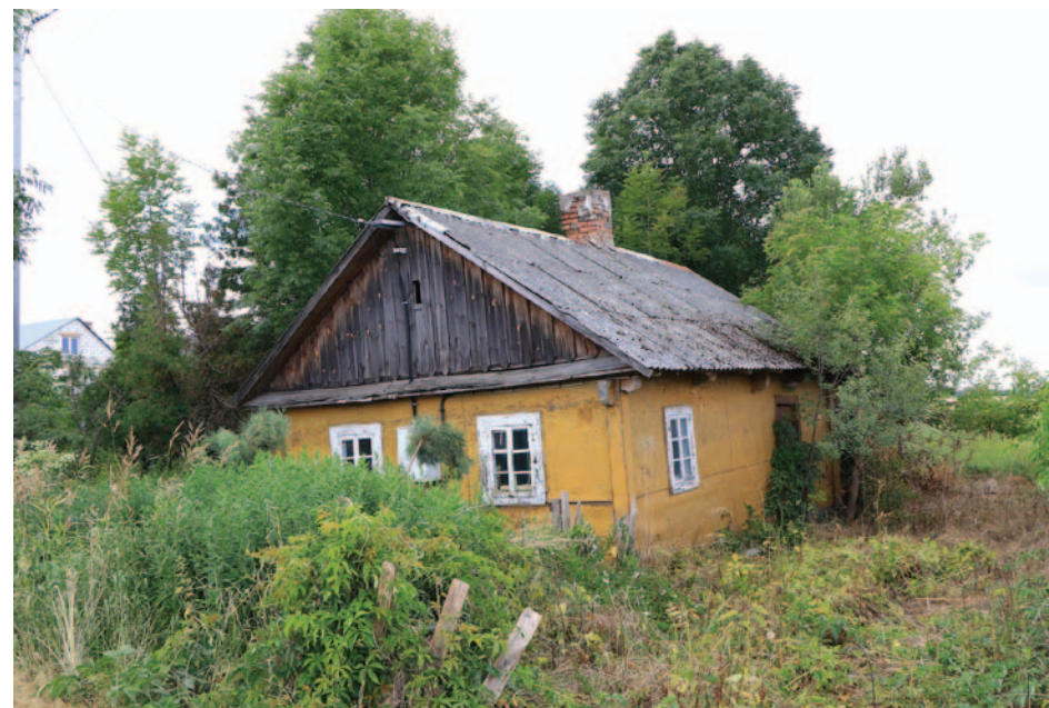
Fot. 23. Szczyt dachu, Wyryki
