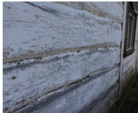
Fot. 17. Uszczelnienie bali, Wyryki
