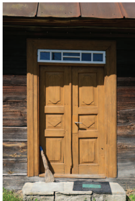
Fot. 32. Drzwi filungowe, dwuskrzydłowe, światlik, Wyryki
