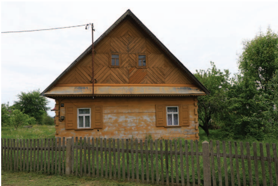
Fot. 26. Szczyt dachu, Wyryki
