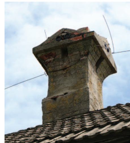
Fot. 28. Komin, Wyryki
