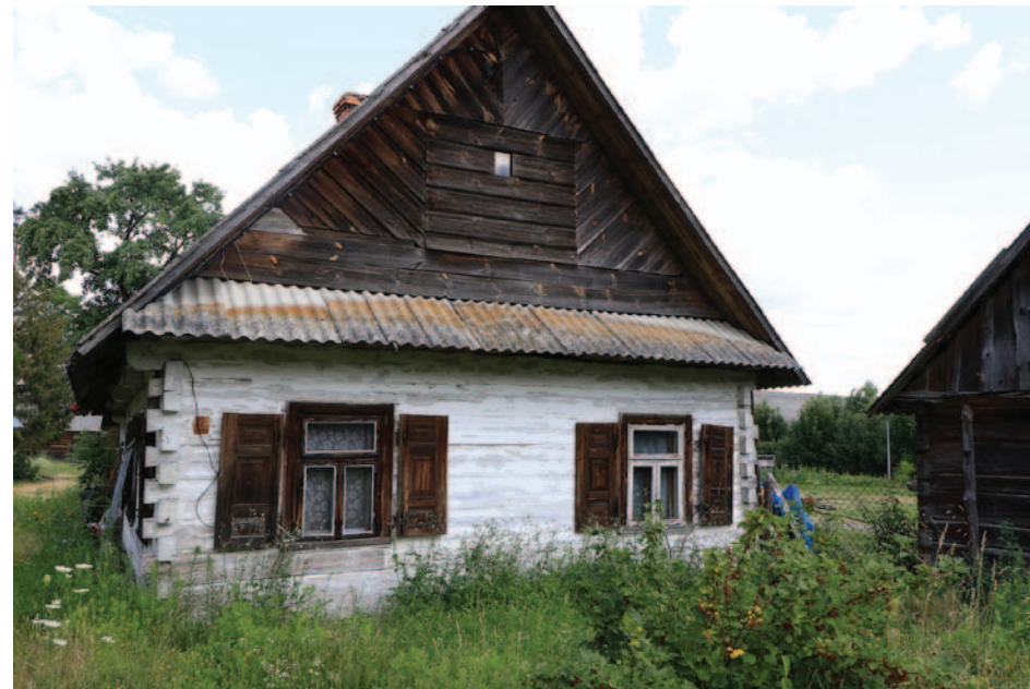
Fot. 24. Szczyt dachu, Wyryki
