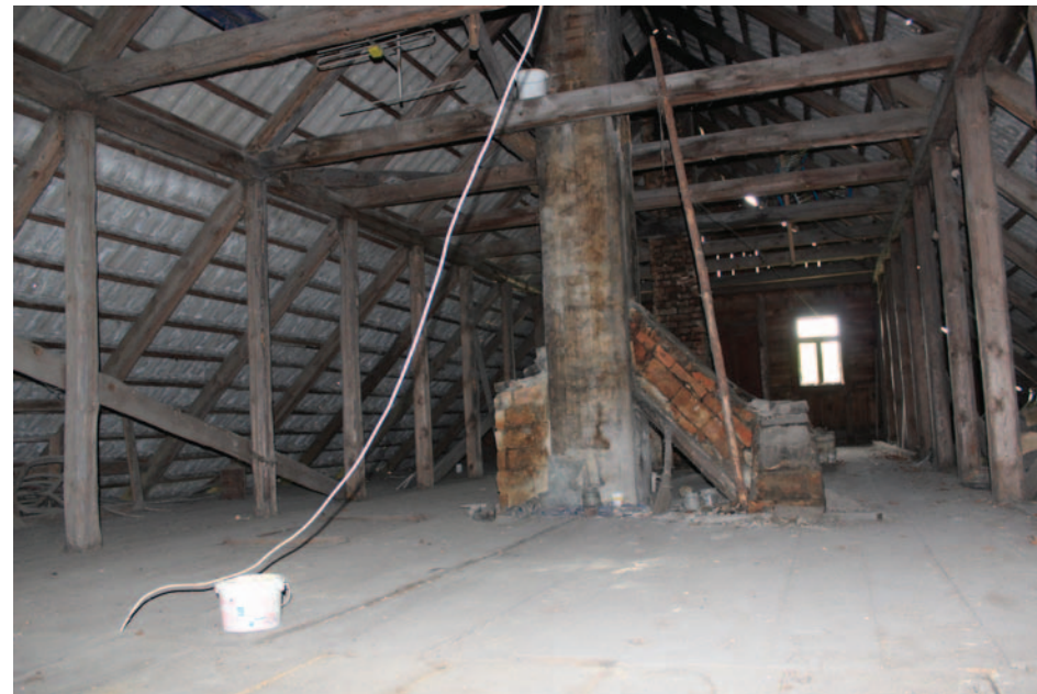
Fot. 22. Konstrukcja dachu krokwiowa na stołek zw. stokową, Wyryki
