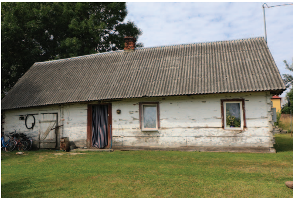
Fot. 4. Chałupa z pomieszczeniami gospodarskimi pod jednym dachem, Wyrki
